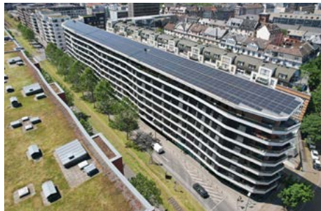
Aktiv-Stadthaus Speicherstraße, Frankfurt
